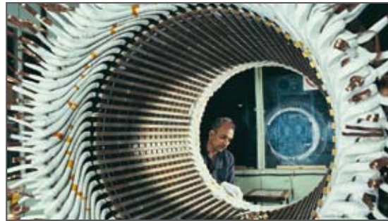
Inspektion eines Generators
